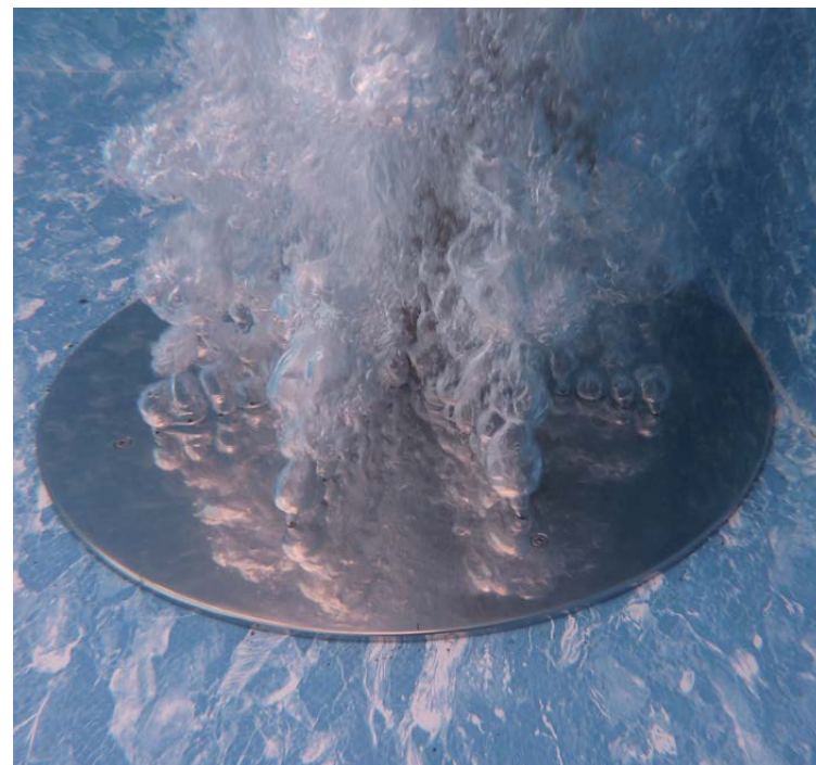
Luftsprudel Massageplatte - Boden Slatiňany
